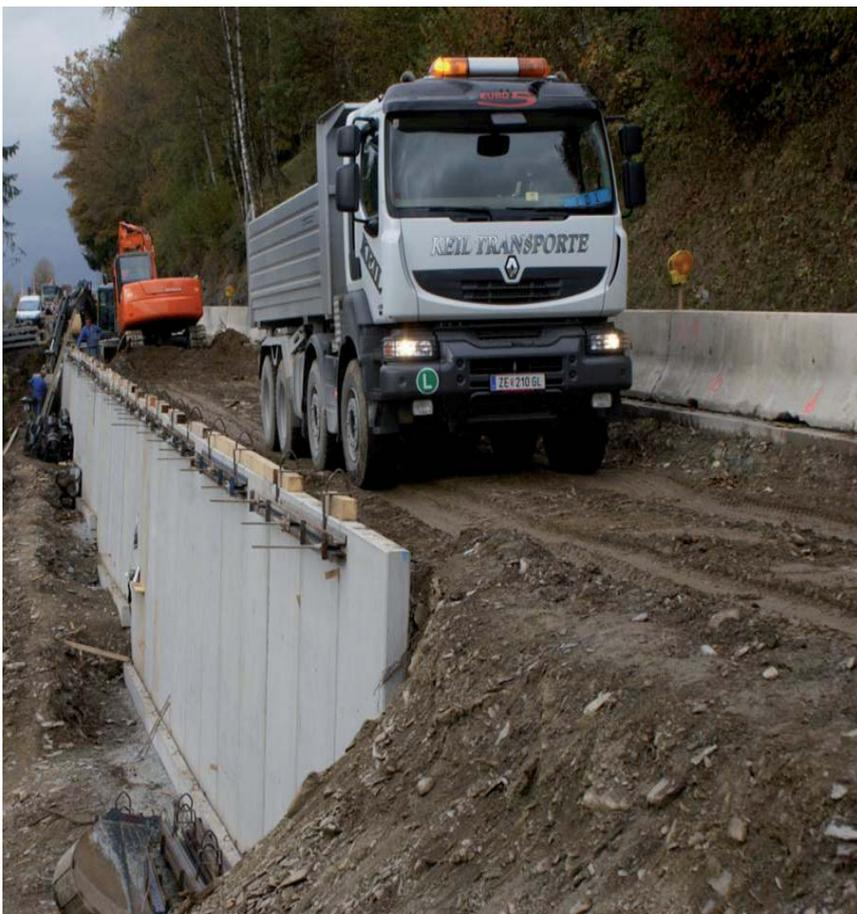
la realizzazione di una platea di fondazione, a meno di un cordolo di pulizia senza funzione statica che ha anche lo scopo di facilitare le operazioni di montaggio.
